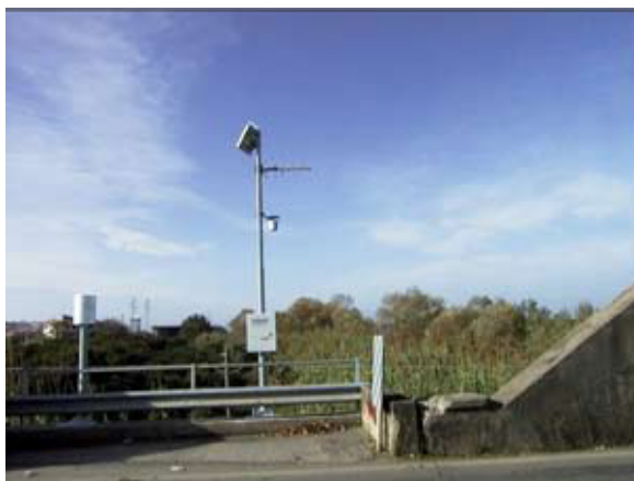
Ponte Mesima – Stazione termopluvioidrometrica di Rosarno
